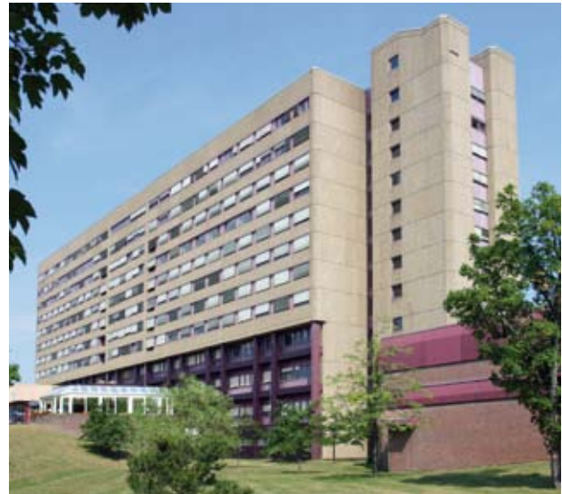
Das Gebäude mit insgesamt 500 Betten ist in zwei Druckstufen untergliedert
