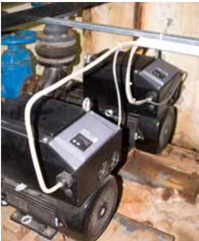
▶ 2 NBE 100-200 für das Multifunktionsbecken
