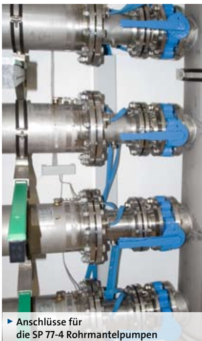
► 4 SP 77-4 als Rohrmantelpumpen eingesetzt
