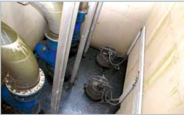
Hocheffiziente, leistungsfähige Grundfos Tauchmotorpumpen der Serie S pumpen das Regenwasser aus den Sammelschächten über die Rückstauenebene hoch
