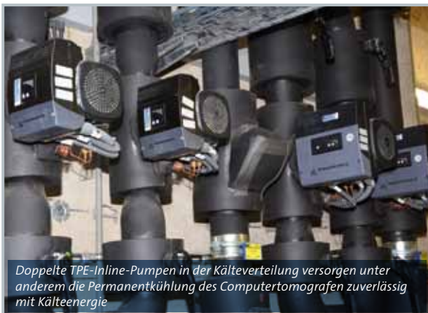
Automatische Grundfos-Druckerhöhungsanlagen vom Typ Hydro Multi-E 4 CRIE 5-10 sorgen netzschonend für einen konstanten Druck im Trinkwassernetz der Klinik
