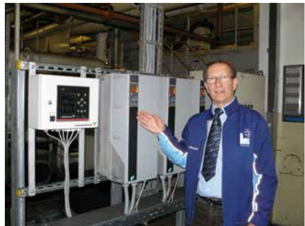
„Erst die neu installierte Steuerungstechnik ist in der Lage zu erkennen, wann die Werkzeugmaschinen weniger bzw. keinen Kühlschmierstoff benötigen und deshalb die Pumpen ganz gestoppt werden können“ (Paul-Gerhard Römermann, Energiebeauftragter im Werk Braunschweig der Volkswagen AG).
