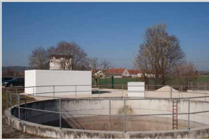
Überblick über die Anlage. Links: das Fertigteilbauwerk für die Steuerungstechnik; Mitte: RÜB; rechts: Fertigteilpumpstation.
