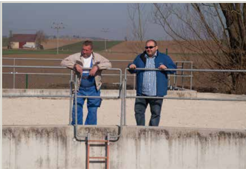
Anlage im März 2014. Links: Klaus Steinmeyer, Gemeindegemeinde Hohenaltheim; rechts: Maik Wötzel, Grundfos Gebietsrepräsentant.
