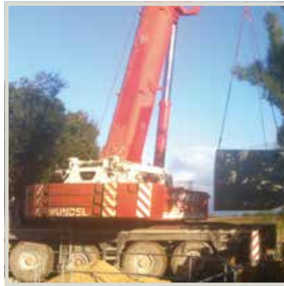
Pumpstation wird vom LKW in die Baugrube abgesenkt
