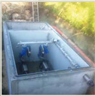
Eingebaute Fertigteilpumpstation
