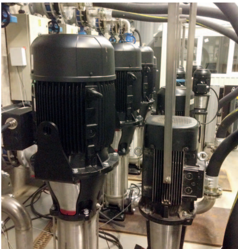
Feldversuche mit der neuen Baureihe CR95 – CR 185 in der Forschungs- und Entwicklungsabteilung Grundfos GmbH
