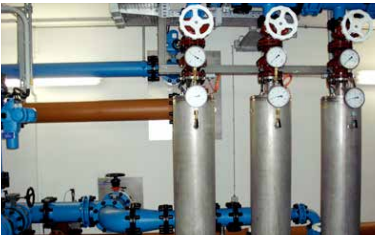
Die alten Rohrmantelpumpen im GPW Wolktersham und DPW Opping werden ausgebaut.
