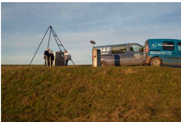
DPW Opping ist unterirdisch angeordnet. Die alten Rohrmantelpumpen werden ausgebaut.
