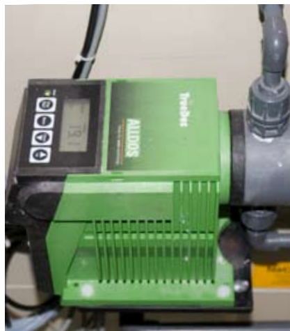
▶ Chlordioxid-Lösung aus dem Batchbehälter wird über eine DDI-209-138 ins Netz injiziert
