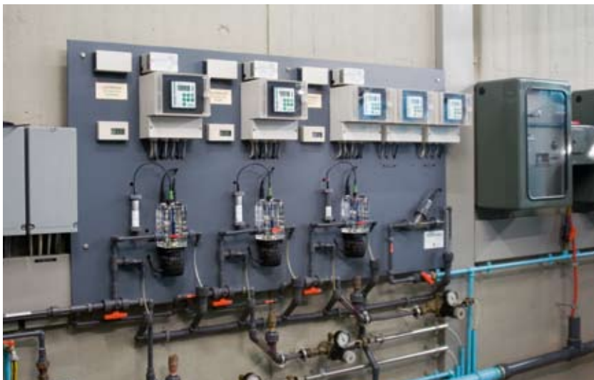
► Messtechnik pH Werte und Eindosieren der Chlordioxidlösung mit 3 DMH 102-10
