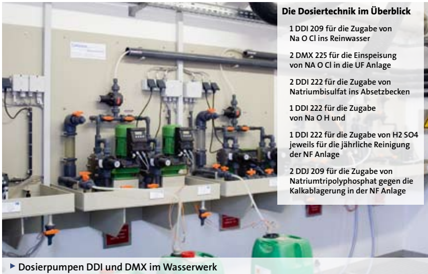
► Dosierpumpen DDI und DMX im Wasserwerk
