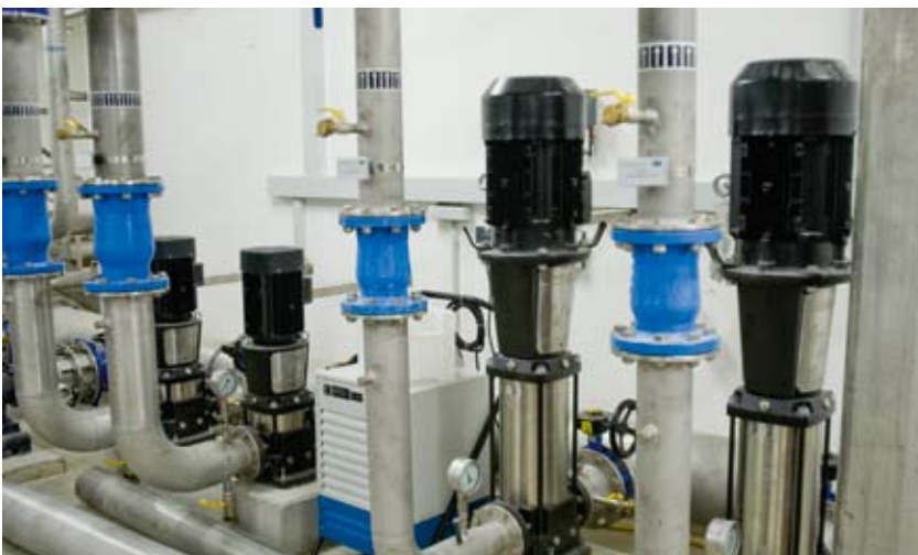
▶ Druckerhöhungsanlagen: links 2 CR 45-5, rechts 2 CR 64-1-1 mit externem Frequenzumrichter
