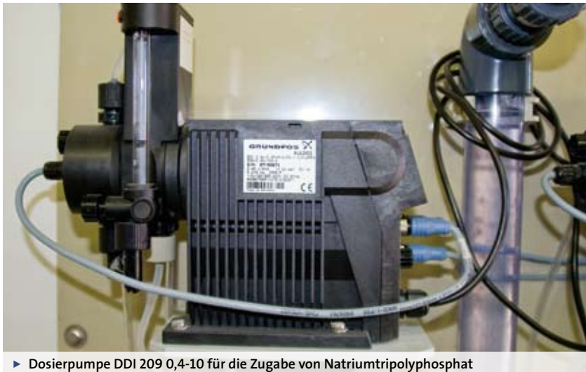
► Dosierpumpe DDI 209 0,4-10 für die Zugabe von Natriumtripolyphosphat
