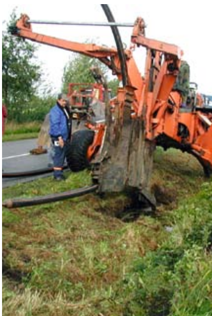
▶ Verlegen der Abwasserdruckleitung von Medelby nach Schafflund
