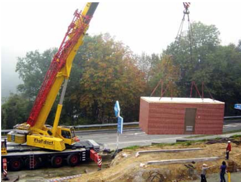
► Pumpstation komplett angeliefert mit Verblendung - wurde auf bauseits erstellten Streifenfundament gesetzt
