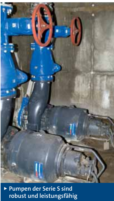
► Eingebaute Grundfos Pumpen direkt nach der Montage
