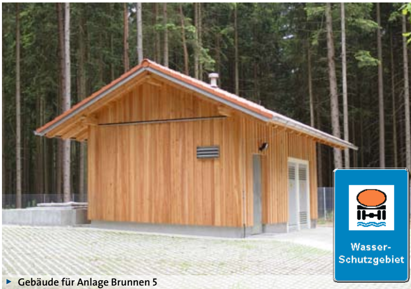
► Gebäude für Anlage Brunnen 5
