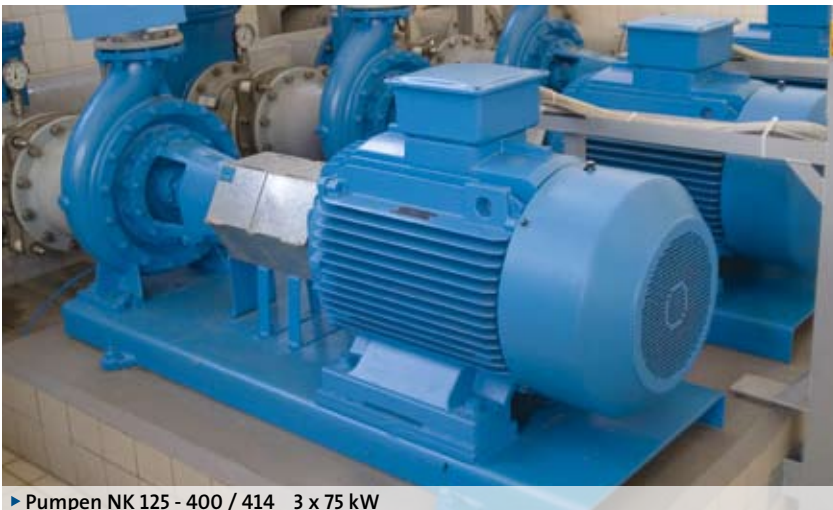
► Pumpen NK 125 - 400 / 414 3 x 75 kW
