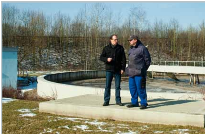
Betriebselektriker Klaus Ruppert (rechts im Bild) mit Grundfos Gebietsrepräsentant Harald Steinbach. Im Hintergrund das Nitrifikationsbecken II.
