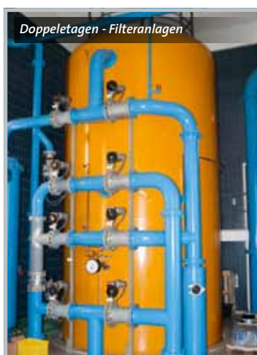
Zuleitungen zu den Rohwasserbehältern
