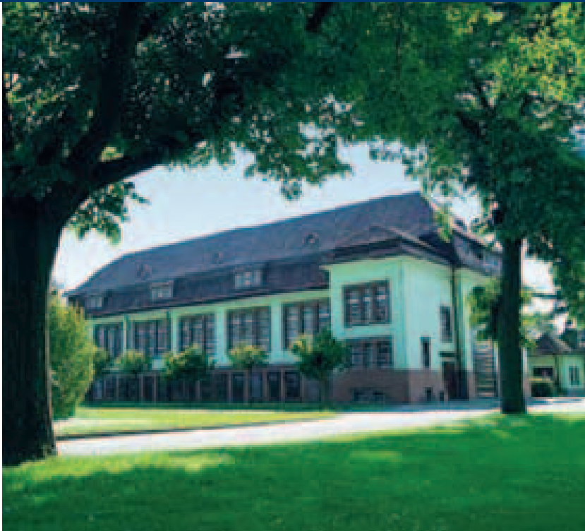
Blick auf das Wasserwerk Rheinau der MVV Energie AG.
