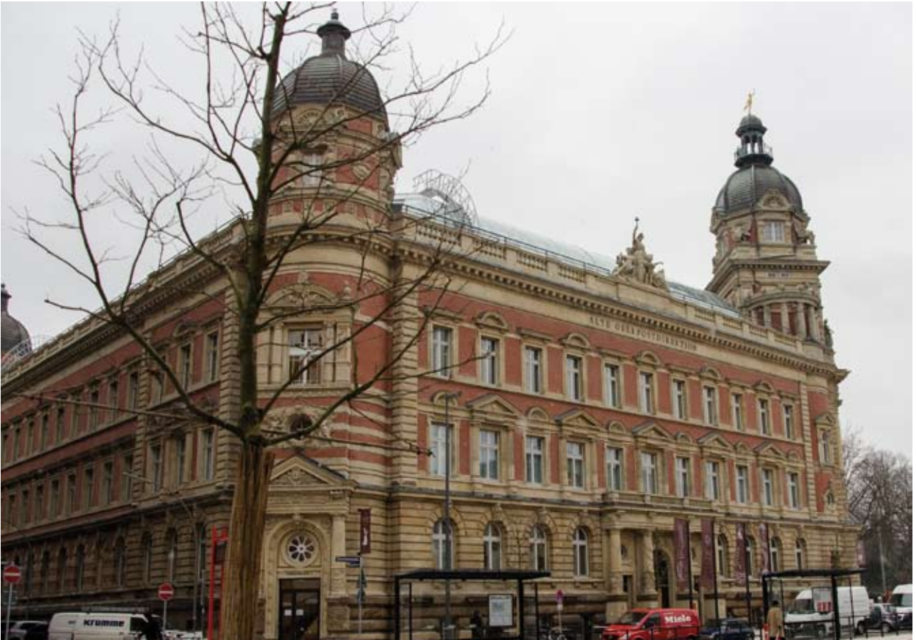
Die Alte Oberpostdirektion mit dem 2011/12 sanierten Ostbau am Stephansplatz gehört zu den bedeutendsten Baudenkmälern in Hamburg
