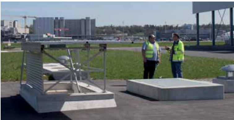
Stapelbecken auf dem Flughafen Zürich. Rechts: Beat Inaven, Projektleiter Wasserversorgung Flughafen Zürich. Links: Maik Wötzel, Gebietsrepräsentant Grundfos.
