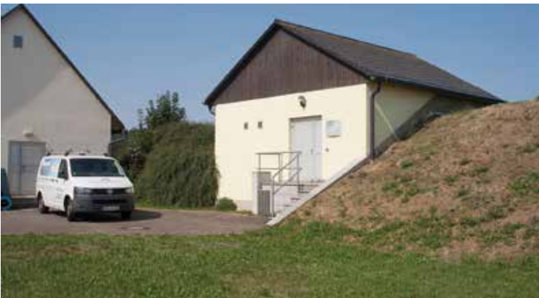
Auf einer Anhöhe vor dem Ortsteil Lengefeld liegen das Gebäude für DEA und Steuerungstechnik sowie der Fernwasserbehälter
