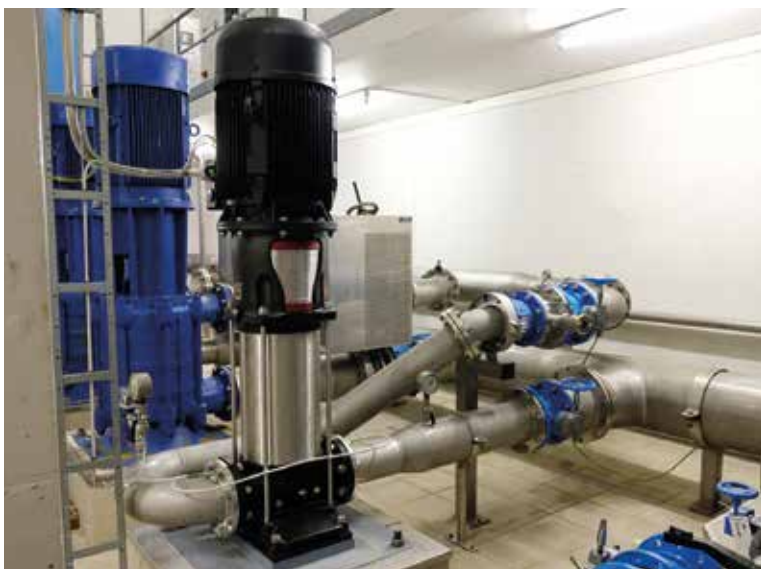
Die Arbeiten zum Umbau der Anlage erfolgten schrittweise. Immer zwei Pumpen mit der dazugehörigen Steuerung waren einsatzbereit
